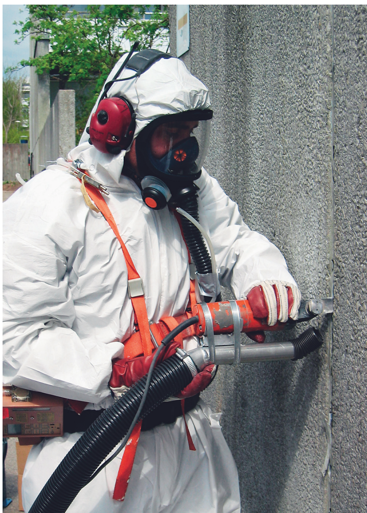
Skärning av fogmassa. Mätningar utfördes innanför andningsskyddet samt i axelnivå utanför andningsskyddet.
