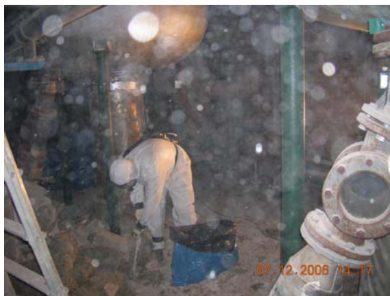
Bild 27. Fyllning av plastpåse med demonterad asbesthaltig isolering. Dammet reflekterar ljuset från fotoblixten.
