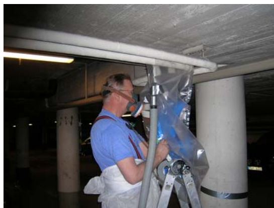
Bild 50. Rivning, dammsugarslangen för undertryck är fasttejpad i ena änden av glovebagen.
