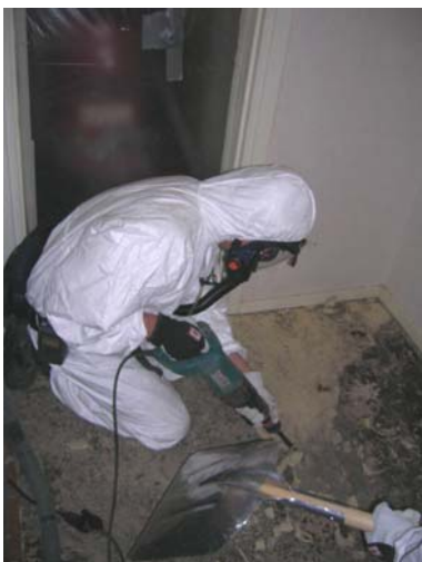
Bild 57. Rivning med mejselhammare.
