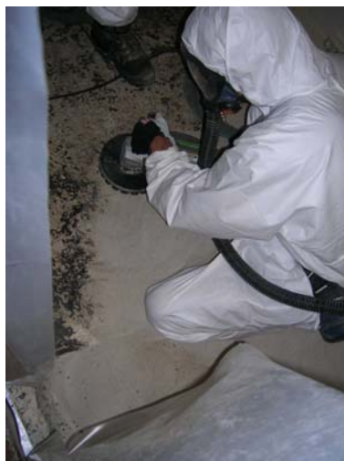
Bild 58. Slipning med vinkelslip med utsug.
