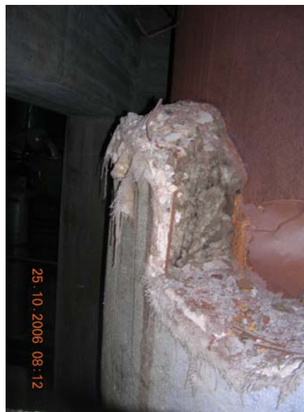
Bild 11. Isoleringen bestod ytterst av 3-5 cm amosit. Innanför asbesten fanns ett ca 10-15 cm tjockt mineralullsskikt samt hönsnät och stålstänger.
