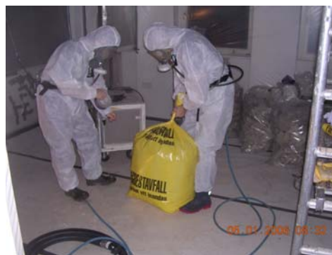
Bild 47. Säckhantering, betydligt mer rivmassor i säckarna jämfört med våtsanering.
