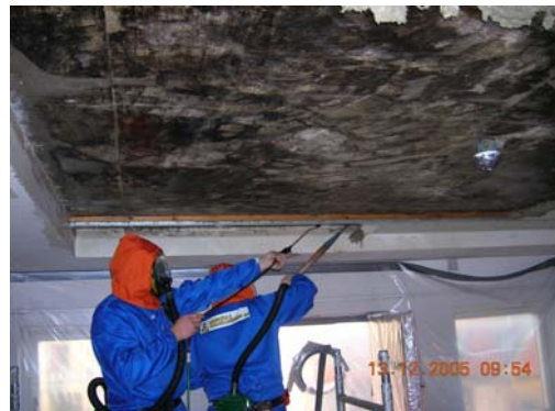
Bild 35. Stötte man på en torr fläck sprayade man isoleringen samtidigt som den revs.
