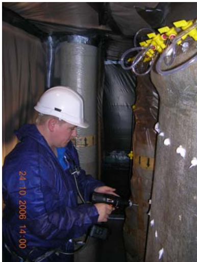
Bild 14. Innan man borrar i isoleringen har man sprayat på rakskum.
