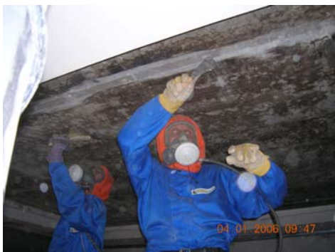
Bild 44. Finsanering med skrapa och stålborste.
