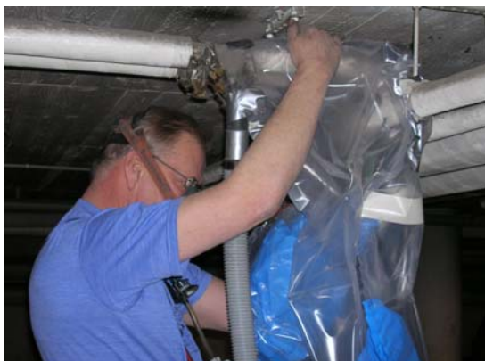
Bild 51. Provtagningskassetten för den personburna provtagningen syns på bröstet på saneraren.
