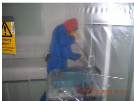
Bild 55. Rivning med kofot.
