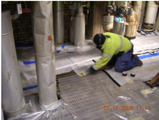
Bild 22. Etablering av våning.
