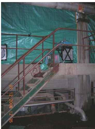
Bild 24. Inkapslingen och fläktar för undertryck samt mätutrustning.
