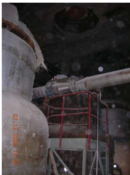
Bild 29. Saneringen av övre delen av pannan klar. Dammet som syns på pannan skall spolas ner. Vattnet skall sedan omhändertas före deponi.
