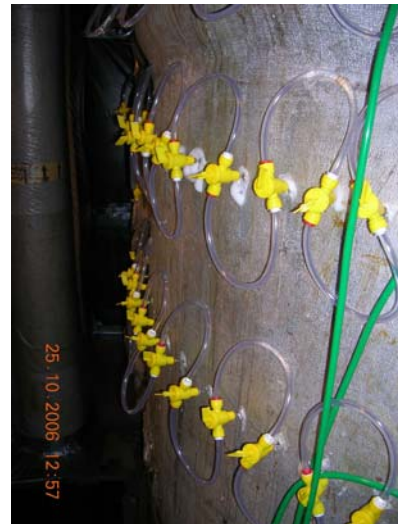
Bild 15 Systemet med nålar när de injicerats.
