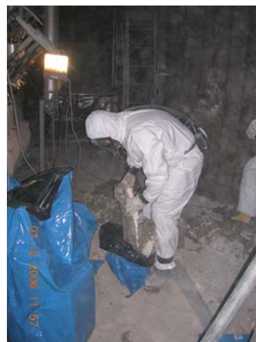
Bild 25. Avfallet läggs i påsar som hissas ner till botten våningen.
