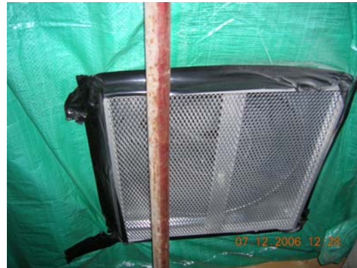
Bild 23. Fläkt som ska hålla undertryck i zonen.
