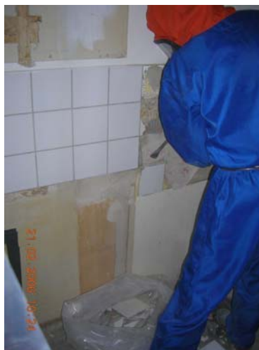
Bild 54. Rivning med mejselhammare.
