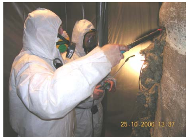
Bild 17. Rivning av isolering. Personen i bakgrunden sprayar om man stöter på torra fläckar.
