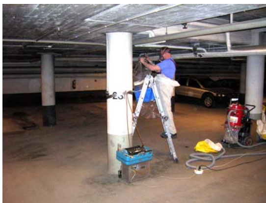
Bild 49. Uppsättning av glovebag, mätinstrumenten står precis nedanför saneraren.
