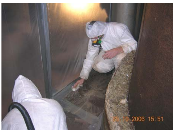
Bild 20. Städning efter slutförd sanering.
