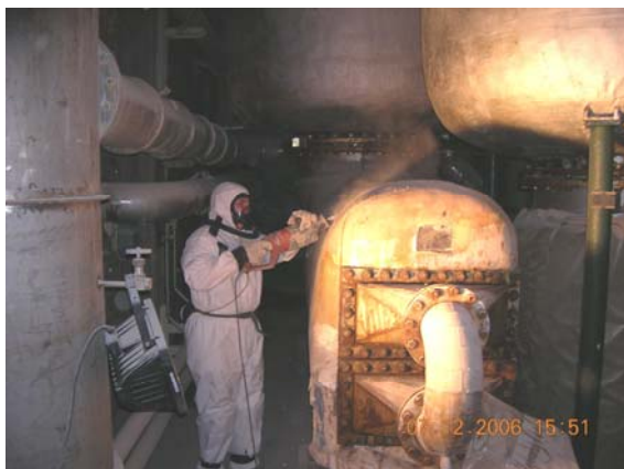
Bild 26. Rivning med tigersåg. Observera dammsprutet från sågen i sågbladets riktning
