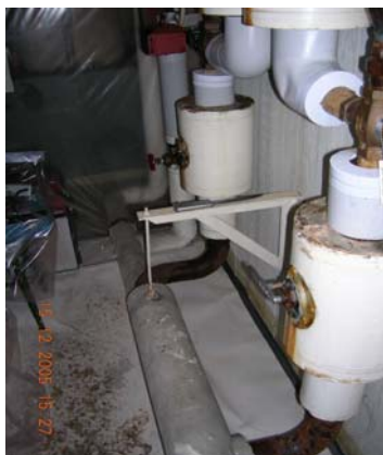
Bild 48. Rörböjar som vätsanerades.
