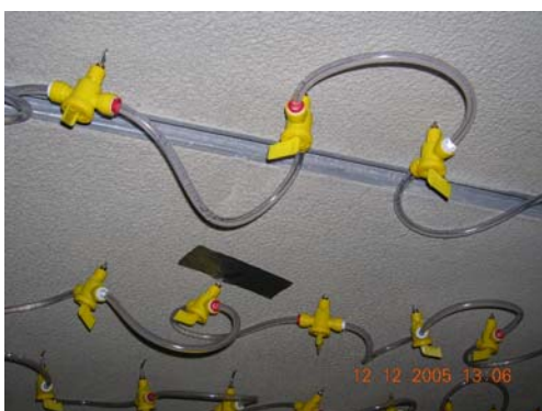
Bild 32. Silvertejp användes på de nålar som man misstänkte kunde släppa.
