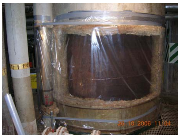
Bild 21. Den sanerade ytan kapslades in efter slutförd sanering eftersom all isolering inte revs under mätningen.
