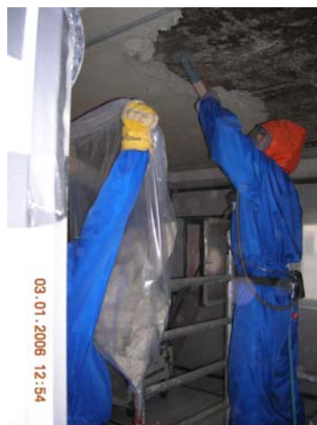
Bild 43. Grovrivning, den ena personen håller upp en avfallssäck för att rivmassorna inte ska falla till golvet.
