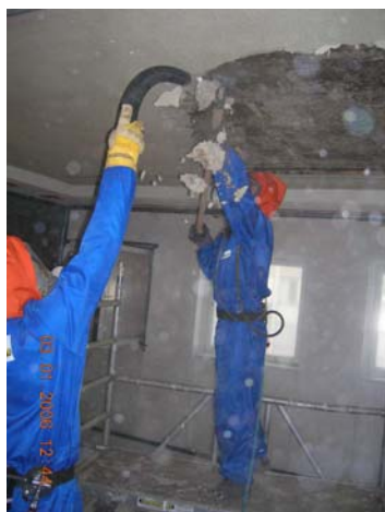
Bild 42. Grovrivning, en person håller dammsugarsslängen när den andra river.
