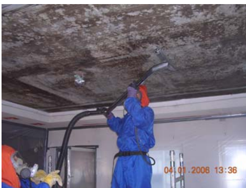
Bild 46. Dammsugning av den sanerade ytan.
