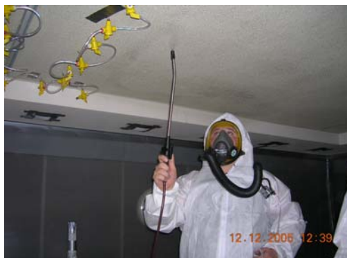
Bild 31. Saneraren sprayar innan han sätter nålarna.
