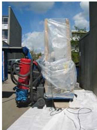
Bild 13: Lift med klen monterat väderskydd.
