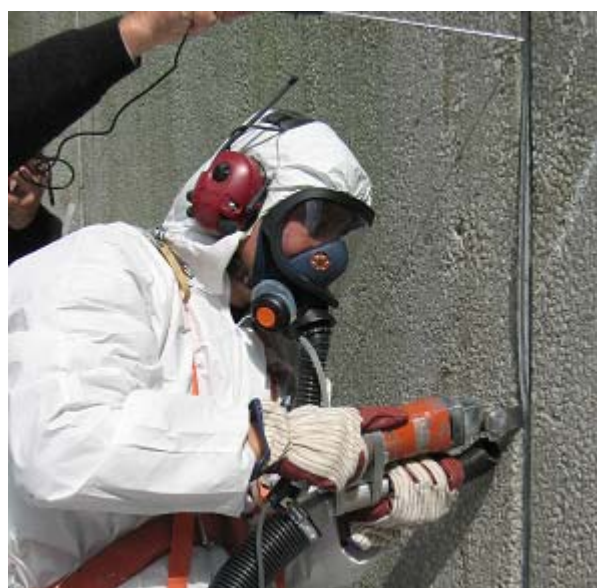
Bild 14: Bilden visar utrustningen för att mäta innanför andningsmasken.
