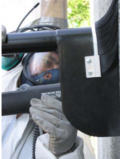
Bild 5: Slipning av fogkanter med vinkelslip Milwaukee AGV 16180 QXC försedd med utsugskåpa från SP.
