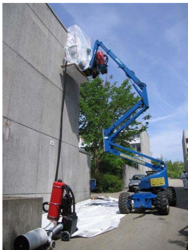
Bild 12: Mätobjektets gavel där de flesta mätningarna genomfördes.
