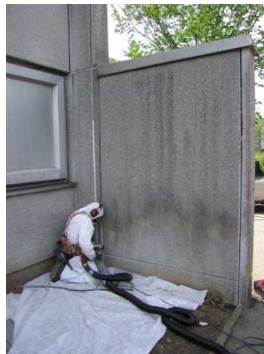
Bild 4: Slipning med raxslip pågår.
